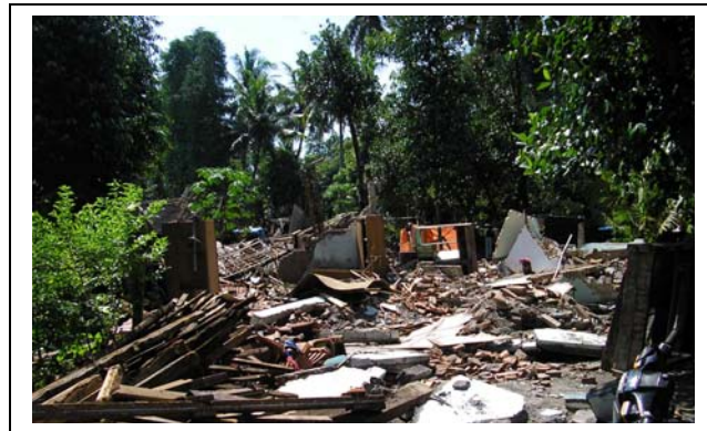
Bild 3 Zerstörungen nach dem Erdbeben vom 27. Mai 2007
